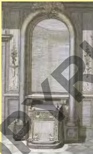
Calorifère Desarnod grand modèle avec ses colonnes (1789 Desarnod)
